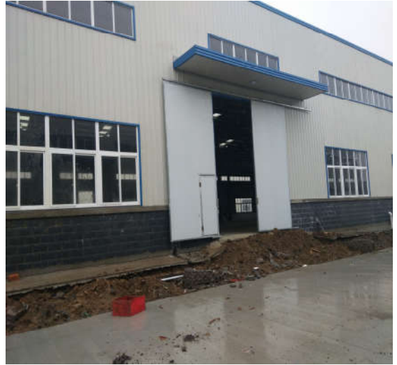
南侧（安徽植美源生物科技有限公司）
