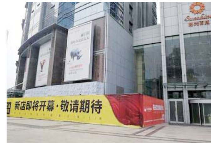
香港中路阳光百货原址拉上围挡正在装修。
