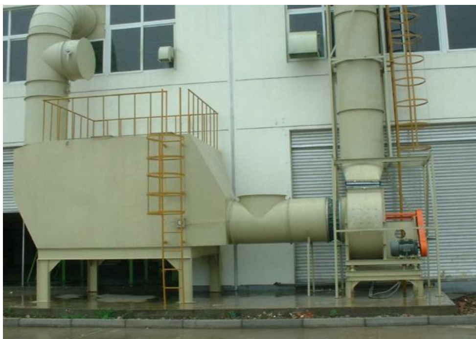
图 7-7 活性炭废气处理柜示意图
