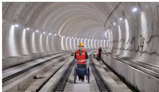
京张高铁清华园隧道具备铺轨条件 目前,京张高铁清华园隧道无砟轨道施工全部完成,已经具备铺轨条件。 新华社记者邢广利摄
