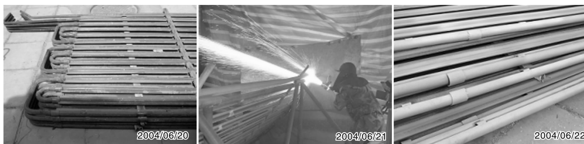
图9 内蒙古海勃湾电厂高温省煤器喷涂前后对比图
