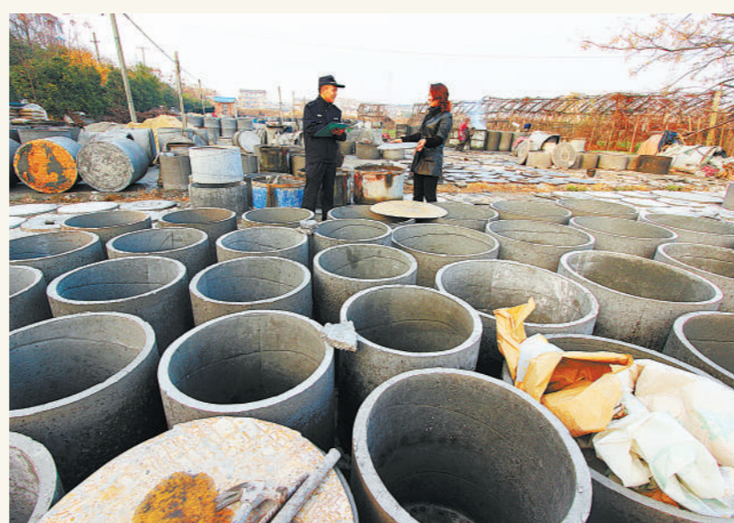
元旦已过,春节日益临近。台州市公安局路桥分局金清派出所深入企业、工地,开展矛盾纠纷的排查化解和劳资纠纷的预防,防范民间纠纷转化成刑事案件,确保社会治安稳定。图为金清派出所民警正在一工地走访并宣传相关常识。 蒋友青 摄
