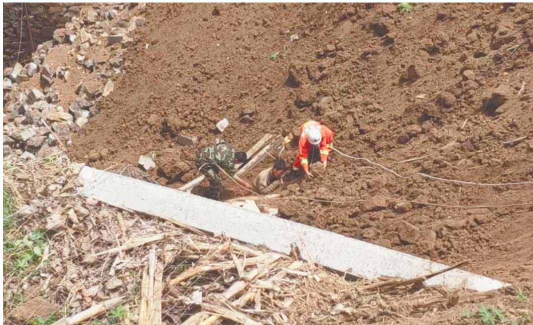
◀消防队员用手和铁锹，对被困人员周围的土石进行清理。(消防供图)
