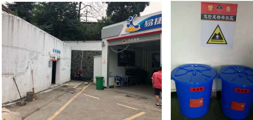
图 3-8 加油站垃圾站及危废暂存区
