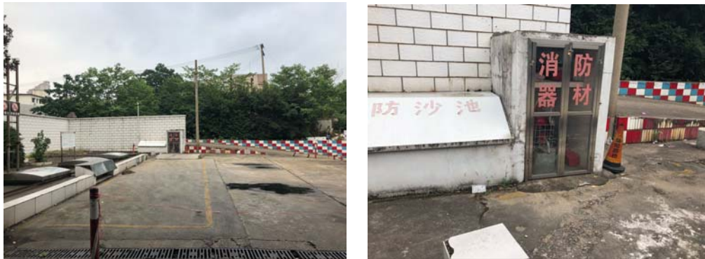
图 3-9 加油站消防设施
