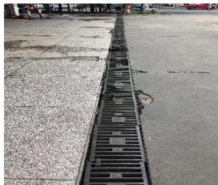
图 3-6 加油区前集水沟
