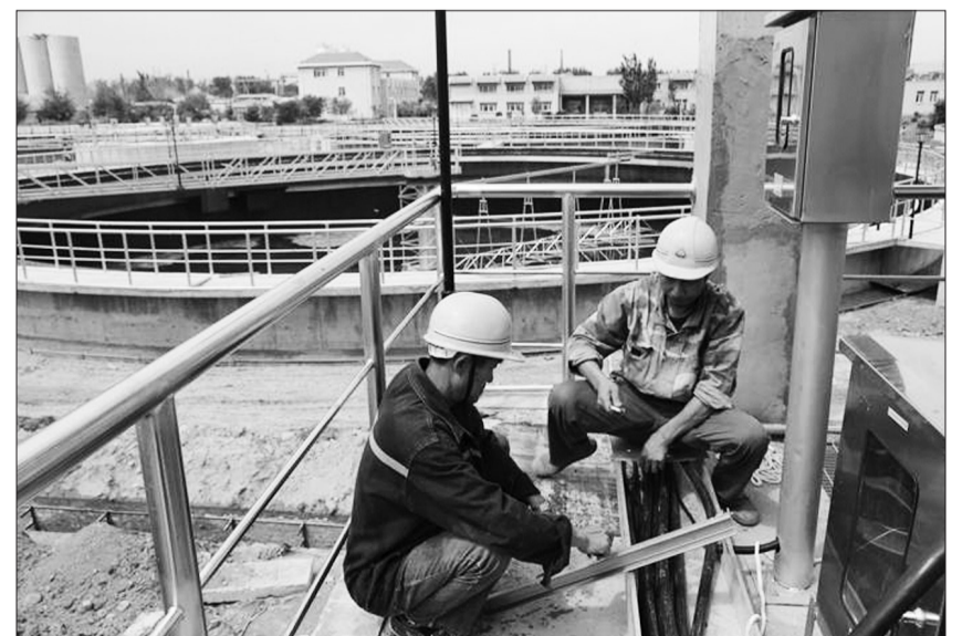
截至目前,包头市列入国家“十二五”重点流域水污染防治的12个项目中,已有5个项目竣工,6个正在建设,已完成投资10.4亿元。图为投资3.5亿元的包头新南郊污水处理厂提标改造工程现场,工人们正在抓紧安装电力设备,以保证月底投入运行。投产后的污水处理厂日处理能力将达到20万吨,成为包头市最大的生活污水处理厂。 本报见习记者李俊伟 通讯员刘清成摄
