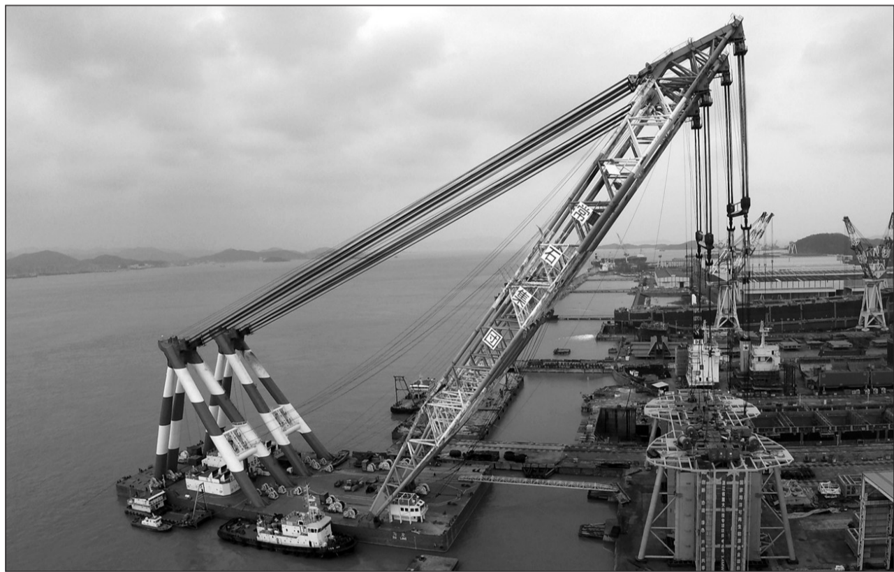
世界首台3.4兆瓦LHD林东模块化大型海洋潮流能发电机组总成平台近日在浙江省舟山群岛新区岱山县秀山南部海域下海安装。据介绍,这台拥有46项核心技术专利的发电机组,是我国海洋清洁能源利用技术上的重大突破,并网发电后,其年发电量可达到600万千瓦时。
