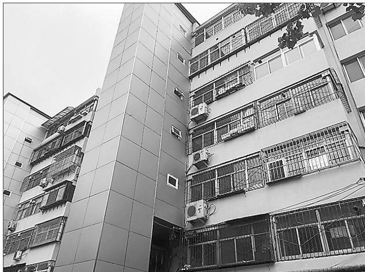
小区内加装的电梯偶尔出现“困人”故障。 记者 张国桐 摄
