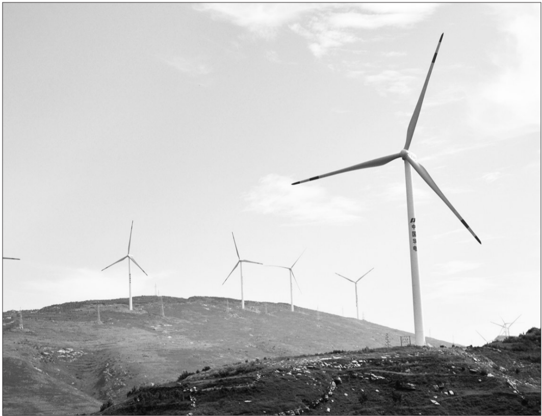
位于河南省洛阳市宜阳县樊村镇的船帆风电48MW项目现场,一个个“大风车”在蓝天白云和青山的映衬下迎风旋转。这标志着洛阳首个风力发电项目正式并网发电,每年可向电网提供约1亿千瓦时的清洁电能。 人民图片网供图
