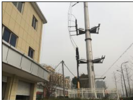
图 6-8 塔基恢复情况
