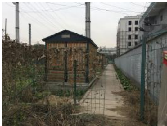
图 6-7 变电站四周恢复情况
