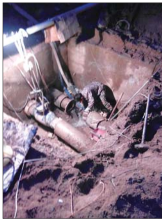
工作人员正在对管网阀门进行抢修。
