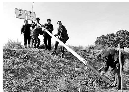
● 扶贫工作队安装太阳能路灯
