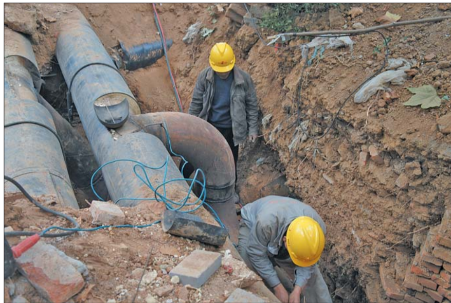
济南热力在对小区内的二次供暖设施进行改造。 本报记者 蒋龙龙 摄
