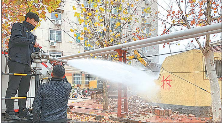
城管正在田庄东路重汽宿舍进行拆违拆临。 记者 李震 摄
