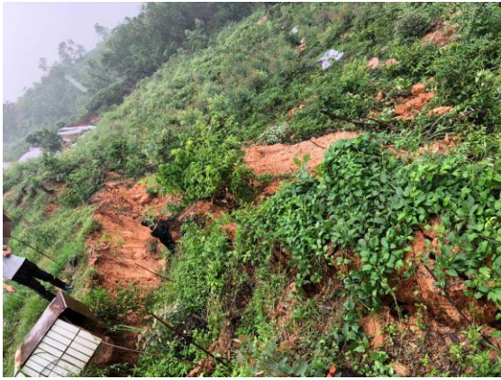
照片 1 崩滑体及裂缝特征，镜向 NW
