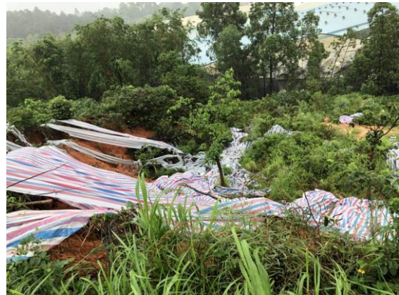
照片 4 滑坡体覆盖的彩条布已被破坏，镜向 NW
