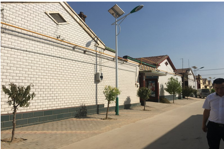
图5: 中国燃气的燃气管道 (黄色)
