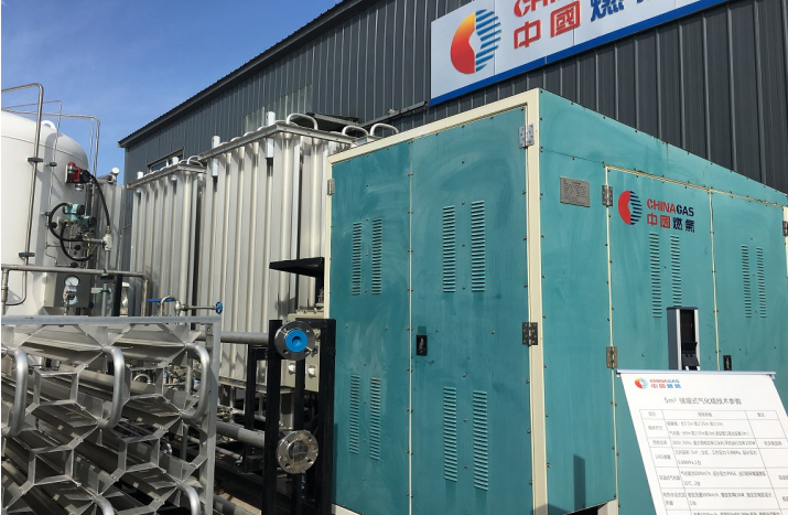
图1: 中国燃气将液化天然气转为天然气的流动设施
