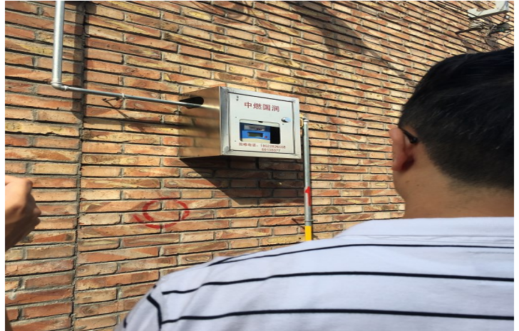
图2: 中国燃气在农村地区设置的家用燃气表
