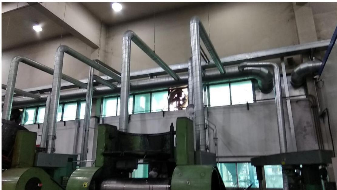
图 9-2 废气排气筒 P1 进气口图
