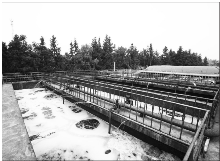
湖南省茶陵县龙华农牧发展有限公司投资兴建的大型养殖污水处理系统,可日产沼气600立方米。
