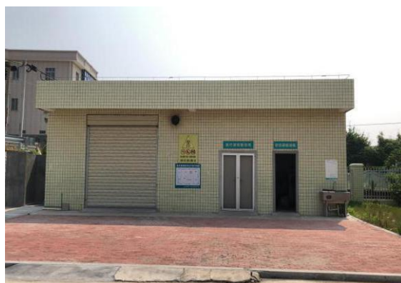
医疗废物暂存间
