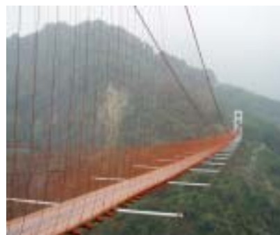
圖六、茂林高吊橋橋面
