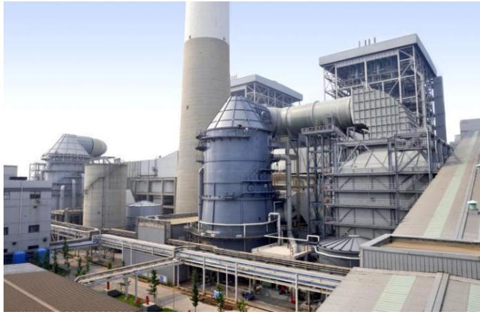
图 1-2 超低排放改造后脱硫系统及湿式电除尘器现场照片
