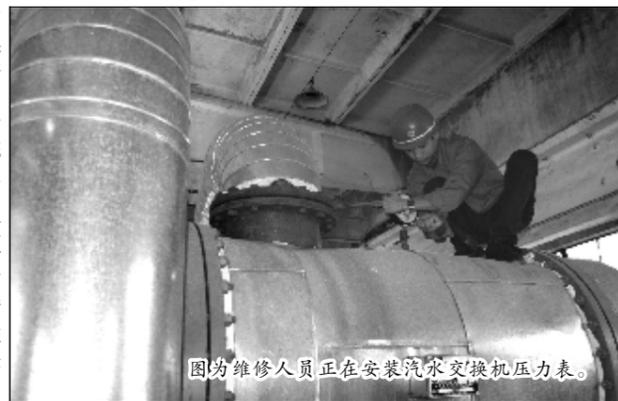
图为维修人员正在安装汽水交换机压力表。
