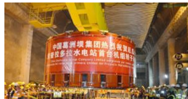
2016年,公司承建的厄瓜多尔索普拉多拉水电站投产,经历了7.5级地震考验
