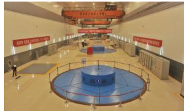
2014年,承建的内蒙古呼和浩特抽水蓄能电站投产发电,葛洲坝掌握了抽水蓄能电站安装调试的核心技术
