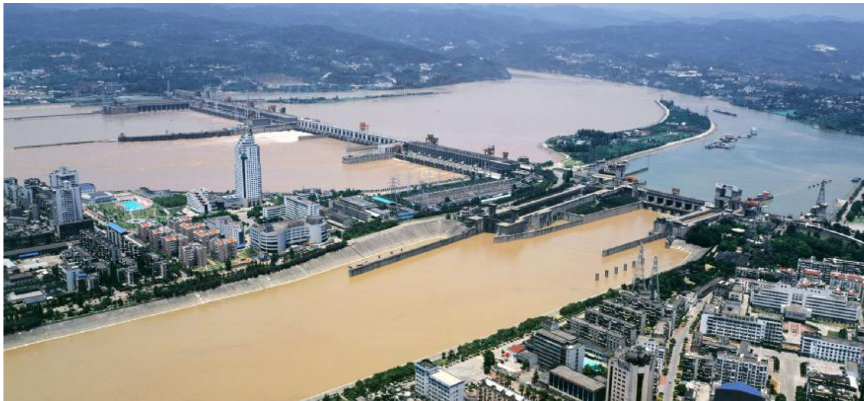
左图,葛洲坝水利枢纽工程建成,标志大型水轮发电机组安装调试技术正式形成。
