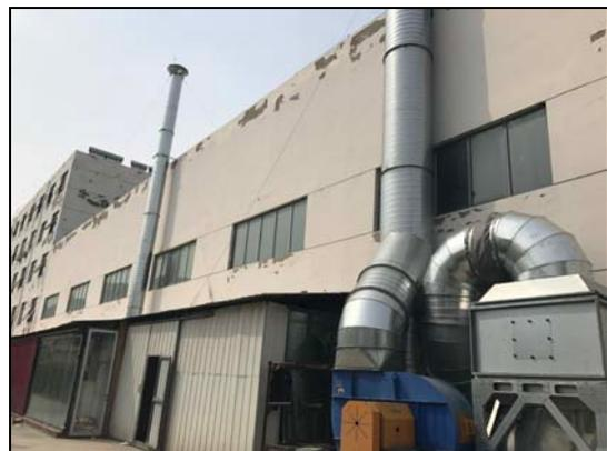
打磨工序和喷漆、烘干工序15m排气筒P2、P3
