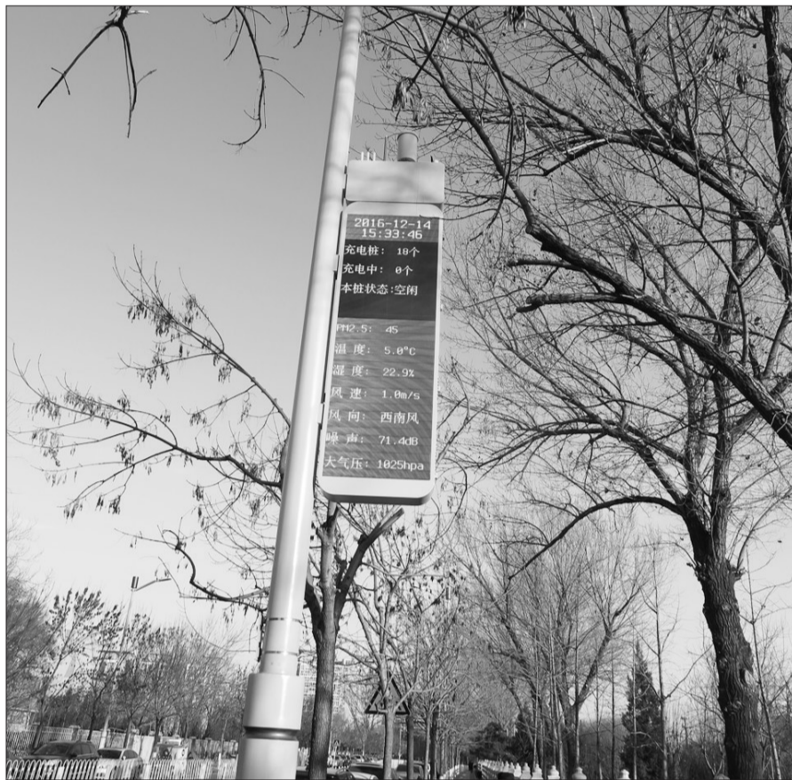
首批20根复合型灯杆近日在北京街头亮相。据了解,这种复合型灯杆通过智慧城市接入平台,实现视频监控、无线城市WiFi覆盖、PM 2.5 智能感知、智能充电桩、市政设施监控等功能。本报记者邓佳摄
