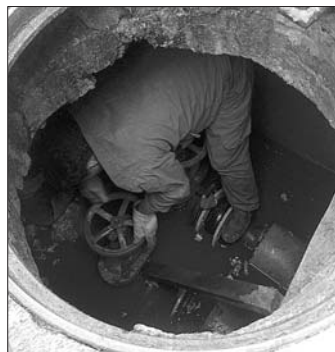
工作人员正维修管道。梁开文 摄
