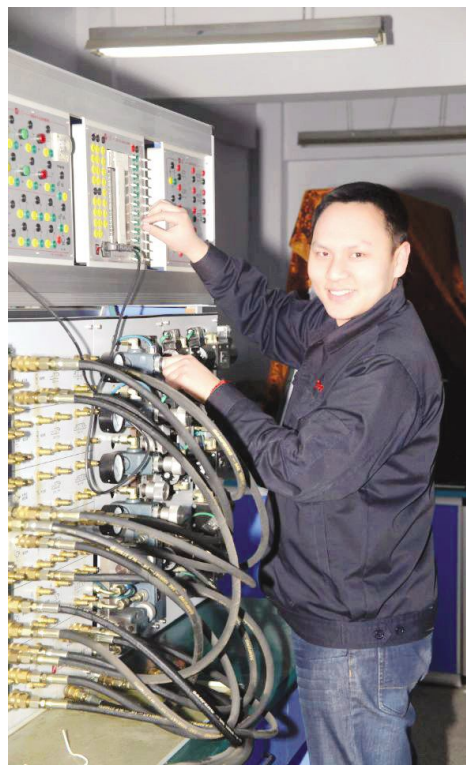
● 图为张涛在调试设备
