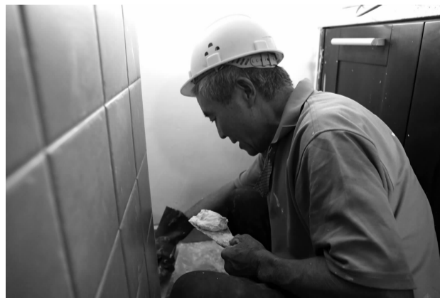
工人粉刷居民家厨房
