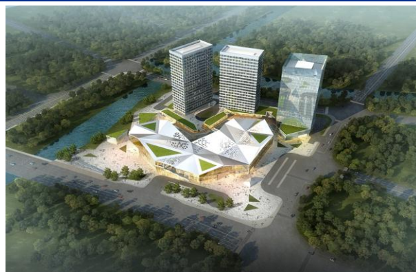
图 6: 阳光城上海浦东新区唐镇商业综合体
