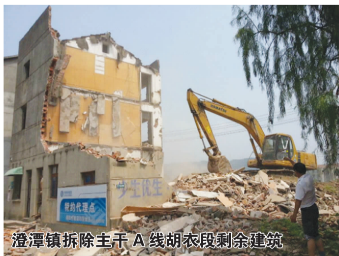
澄潭镇拆除主干A线胡衣段剩余建筑
