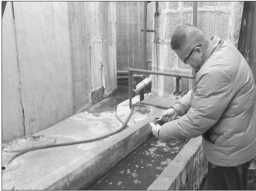
图为环境执法人员现场检查企业脱硫设施。 王飞摄
