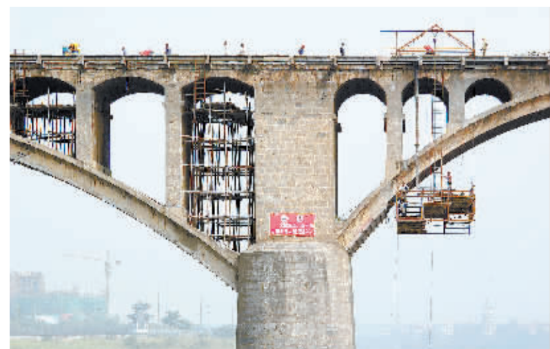
国庆期间,工人们正利用晴好天气对永州市零陵区东风大桥桥身进行加固维修。周承伟 摄
