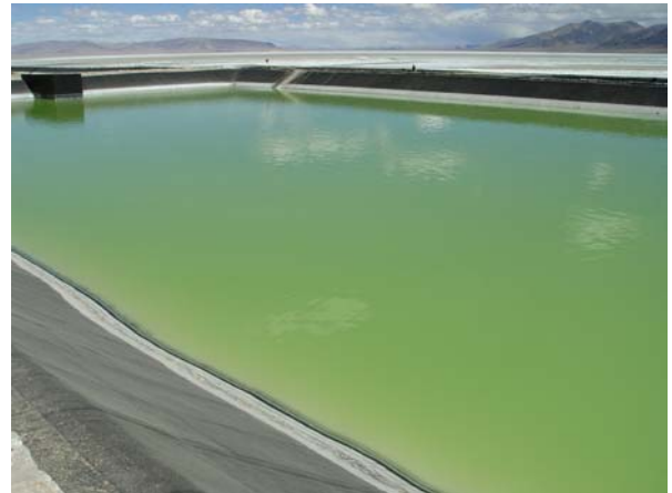
图 4 正在运行中的扎布耶盐湖结晶池 Fig. 4 Crystallization pond in operation at Zabuye Salt Lake
