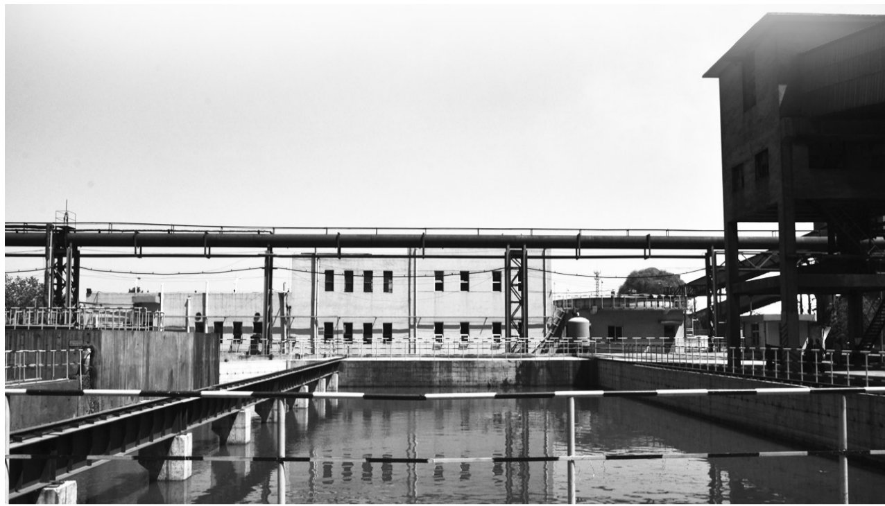
图为德龙钢铁污水处理中心
