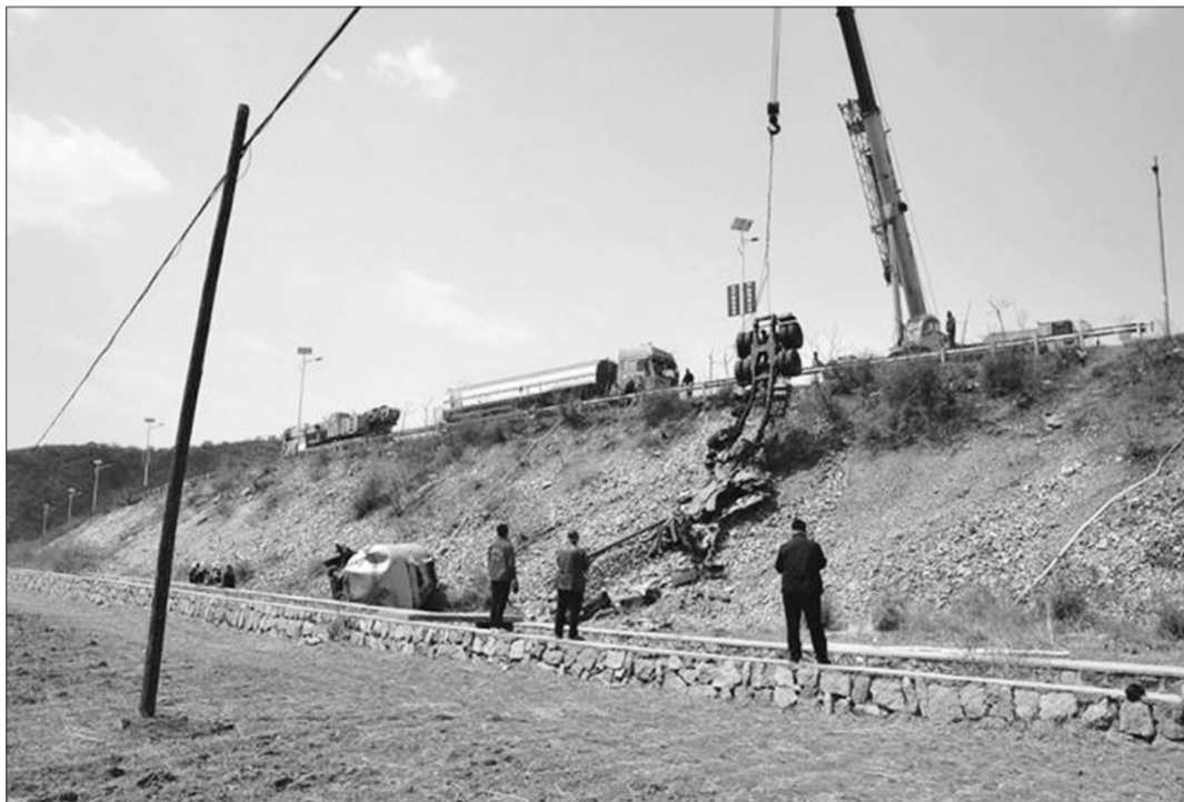
辽宁省葫芦岛市日前成功处置一起苯罐车侧翻泄漏事故。一辆载有苯的罐车日前在葫芦岛市建昌县306国道马道岭路段发生侧翻,滚入路边农田,导致苯泄漏。葫芦岛市立即成立现场指挥部,组织消防、环保等部门赶赴现场,疏散周边村庄十几户村民,对罐体和泄漏部位实施泡沫覆盖、稀释。经环保部门现场监测,事故发生地及周边,无河流等环境敏感目标。目前,葫芦岛市环保部门已调用应急救援抽油车对苯泄漏现场进行处置,事发现场已得到有效控制。张勇摄
