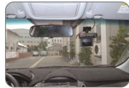
安裝佈線完成圖
