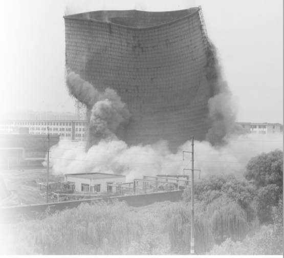
图为魏桥创业集团3万千瓦热电小机组爆破现场。
