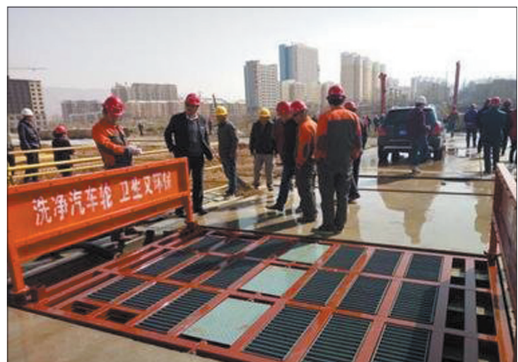
为实现建筑施工现场节后安全有序复工,山东省临沂市近日下发通知,要求工程项目复工前要对施工工地扬尘治理等全面检查。同时,还要求各县区监督机构组织工作人员对辖区内在建工程全面巡查,对复工检查搞形式、走过场的项目重点检查。对发现复工检查不到位、存在较多隐患及扬尘治理措施未落到实处的项目,一律不予复工。
