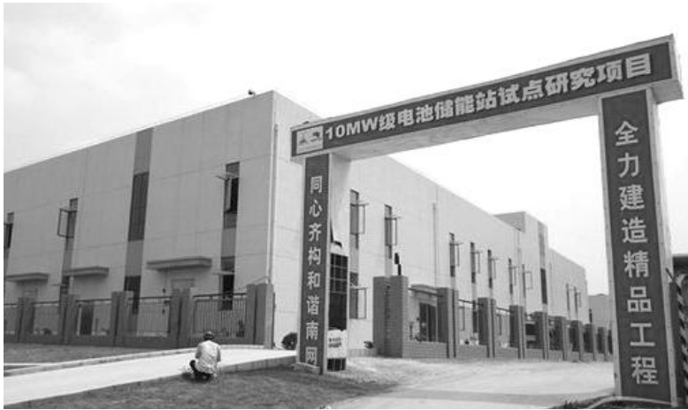
南方电网深圳宝清储能站是中国第一个兆瓦级电池储能站。
