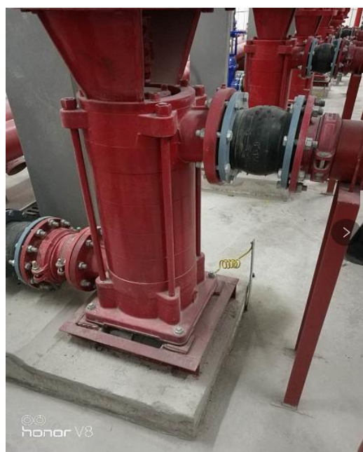
设备基础减振及软连接
