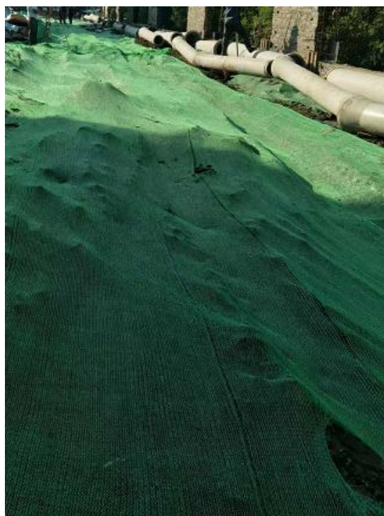
对施工现场苫盖
