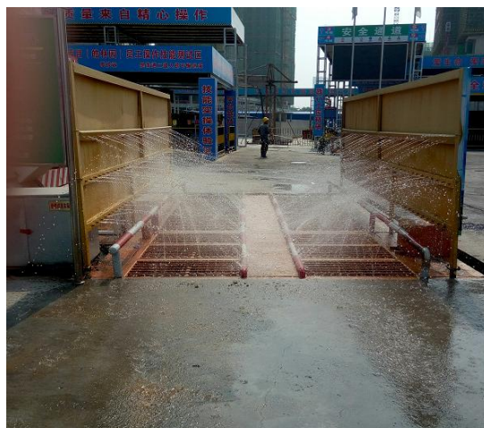
工地出入口对出入车辆车轮冲洗
