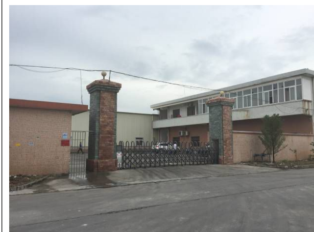
项目西面厂房
