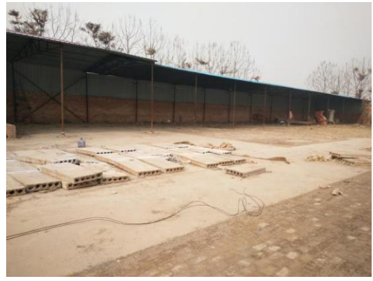
拟建探伤室南侧待建车间
