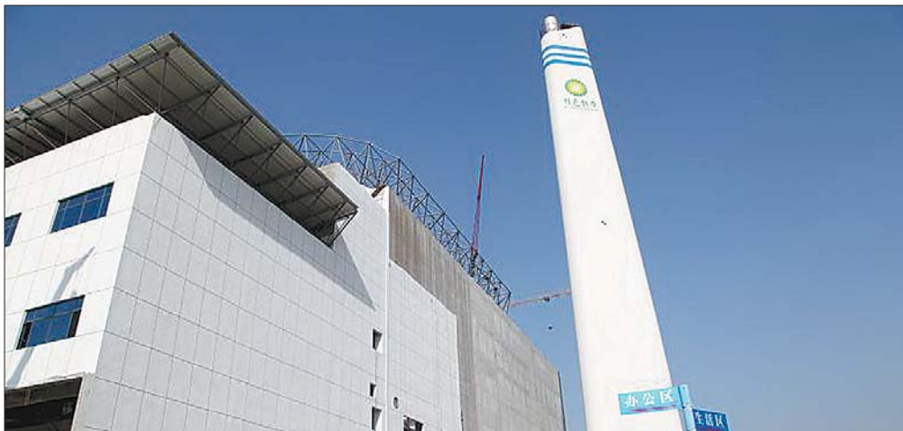
焚烧发电厂让生活垃圾实现无害化、减量化、资源化处理。
