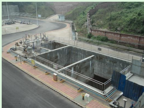
新建污水收集池
