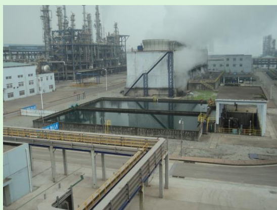
依托消防水池
