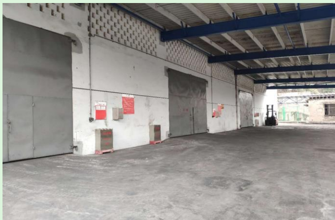
川维公司危废暂存间
