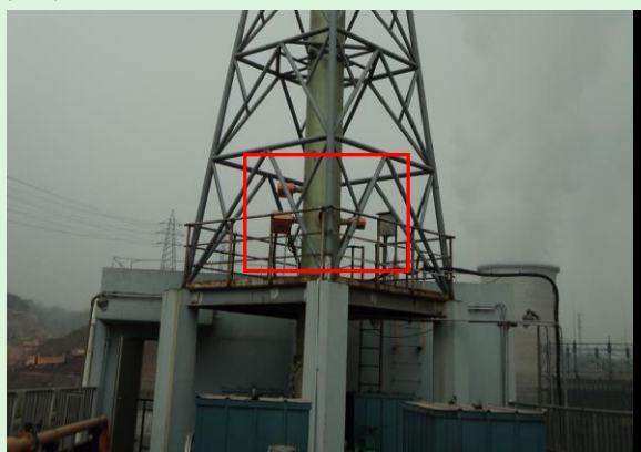
废气采样孔及平台
