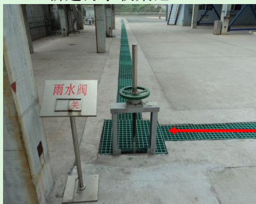
雨水沟及雨水截断阀
