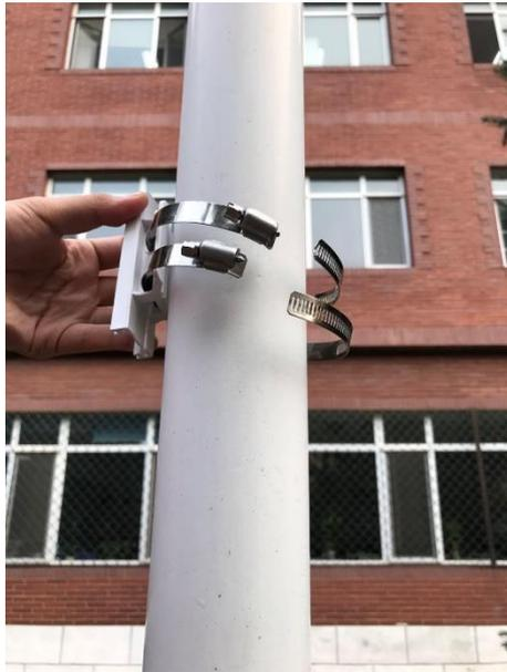
3. 使用一字螺丝刀拧紧安装箍，注意安装支架的方向，带有软扣的一侧在下面。
