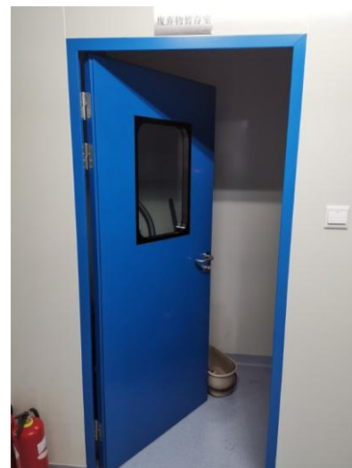
废物暂存间实景图
