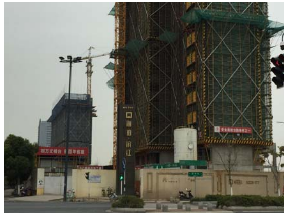
管道沿线在建住宅
