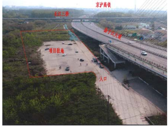
施工营地选址
