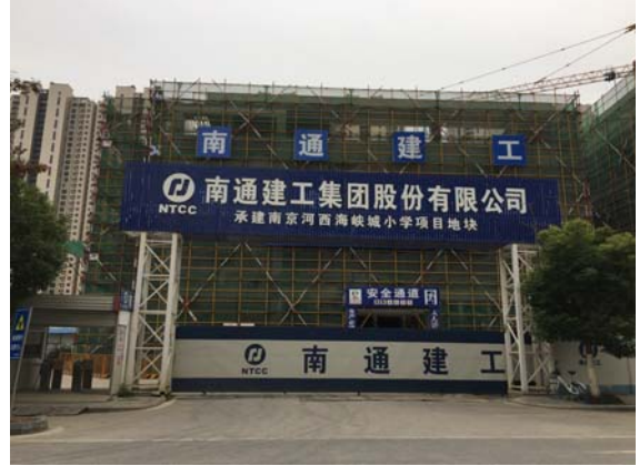
管道沿线在建小学
